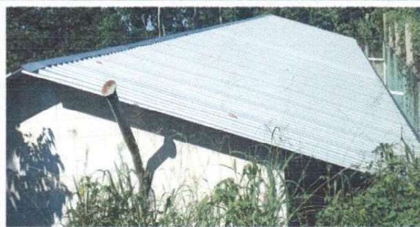
FOTO 2: SUSTITUCION DE LAMINA POR LAMINA TROQUELADA ALUCIN CALIBRE 26, AULA.
