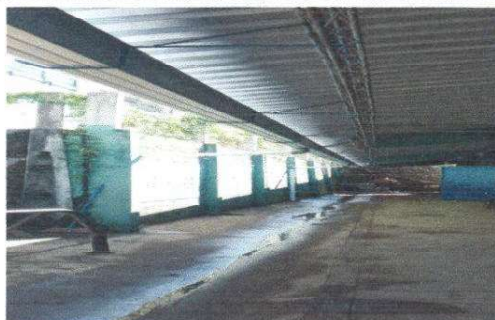
FOTO 6: SUSTITUCION DE BAJADA DE AGUA PLUBIAL DE METAL POR TUBO PVC 3 ''
