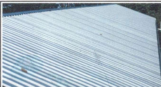
FOTO 1: SUSTITUCION DE LAMINA, POR LAMINA TROQUELADA ALUCIN CALIBRE 26, AULA.
