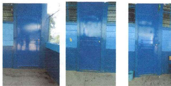
FOTO 4: SUSTITUCION DE PUERTAS DE METAL.
